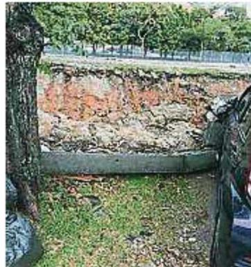
▲柏西兰巴迪的沟渠疑因有裂痕和排水冲撞而坍塌。
